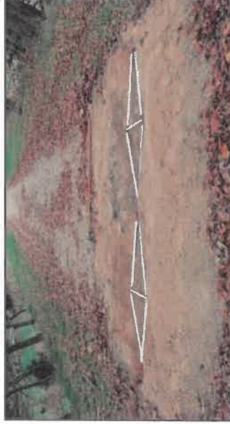
Figura 164: Bucă de inducție încorporabilă în drumul neasfaltat
