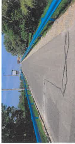
Figura 163: Contor de biciclete instalat pe un drum cu trafic redus (Kisköre, Ungaria)
