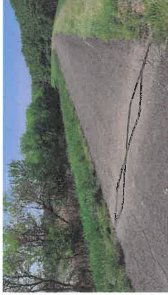
Figura 162: Contor de biciclete instalat pe un dig de protecție împotriva inundațiilor (Sarud, Ungaria)
