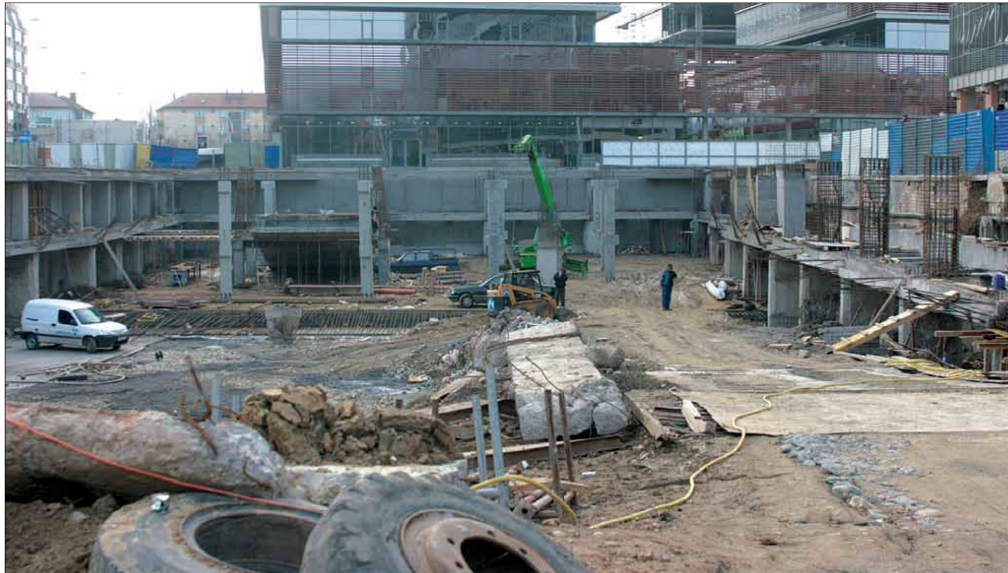
Singura parcare subterană din Timișoara este încă în construcție
