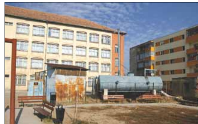
Sonda de apă geotermală din spatele școlii din Sănnicolou Mare
