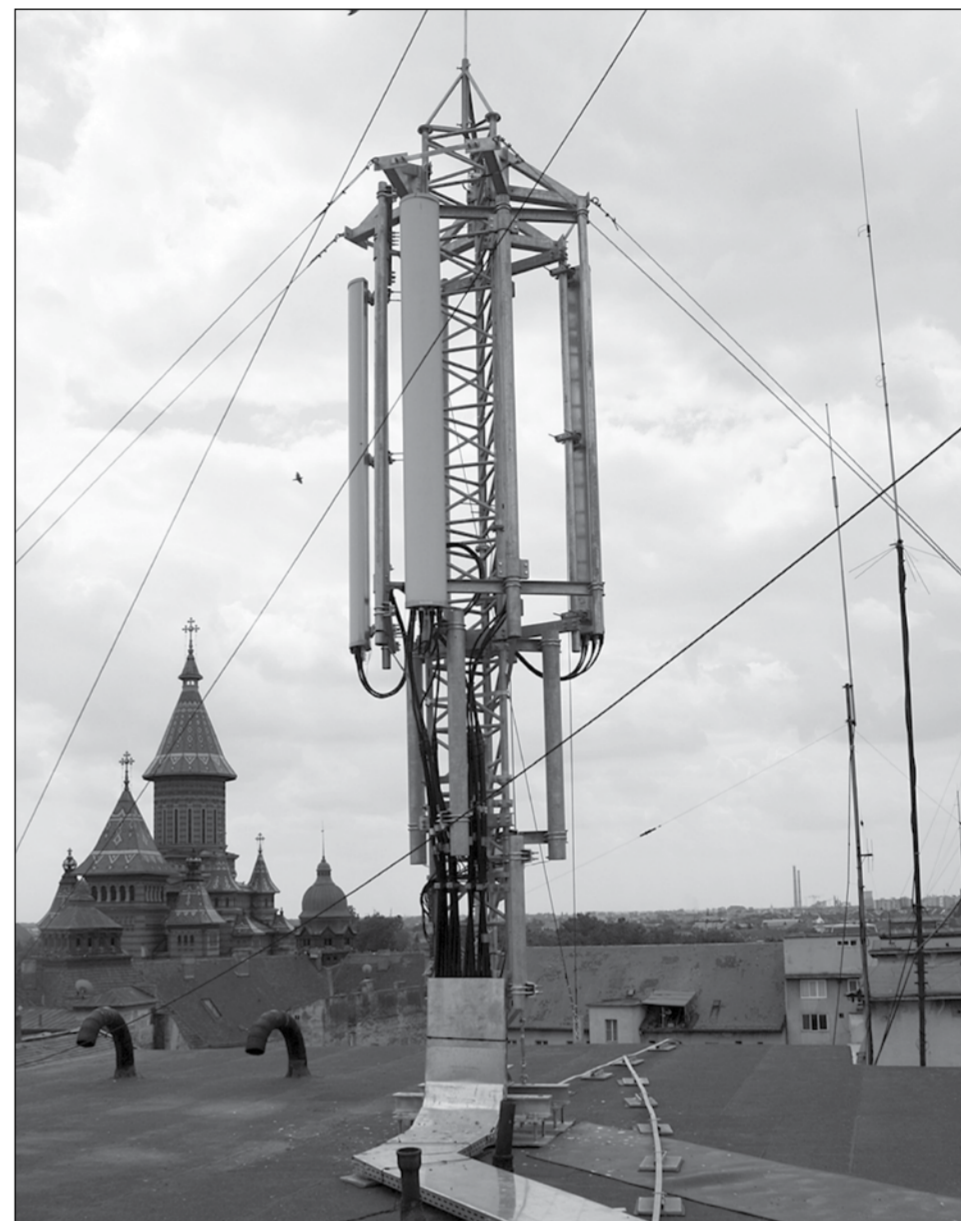
Operatorul de telefonie mobilă a avut nevoie de 150 de metri pătrați pentru montarea antenei
