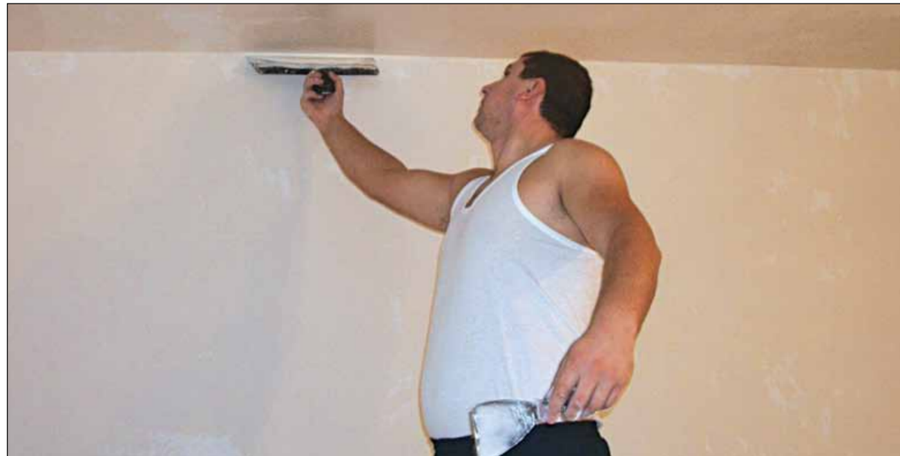
Pereții afectați de igrasie trebuie curățați cu grijă
