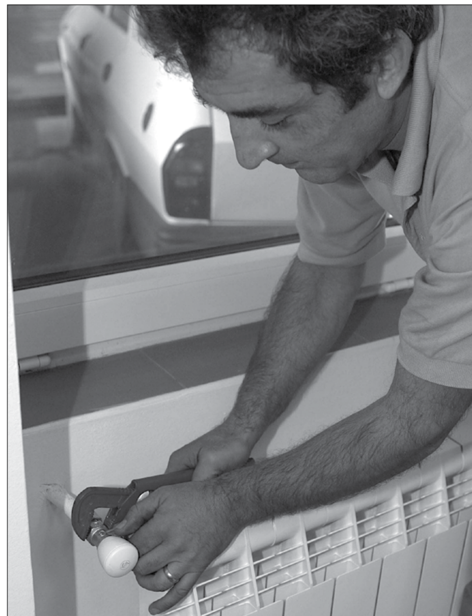
Numărul timișorenilor care se debranzează ilegal a crescut alarmant
