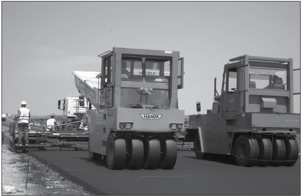
Lucrarile la autostrada Arad-Timișoara vor fi finalizate în luna decembrie
