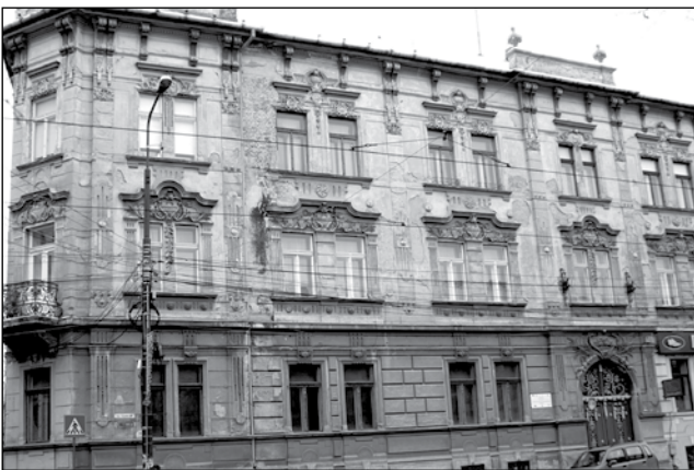
Primăria Timișoara va avea obligația să inventarieze toate clădirile care necesită reabilitarea fațadelor
