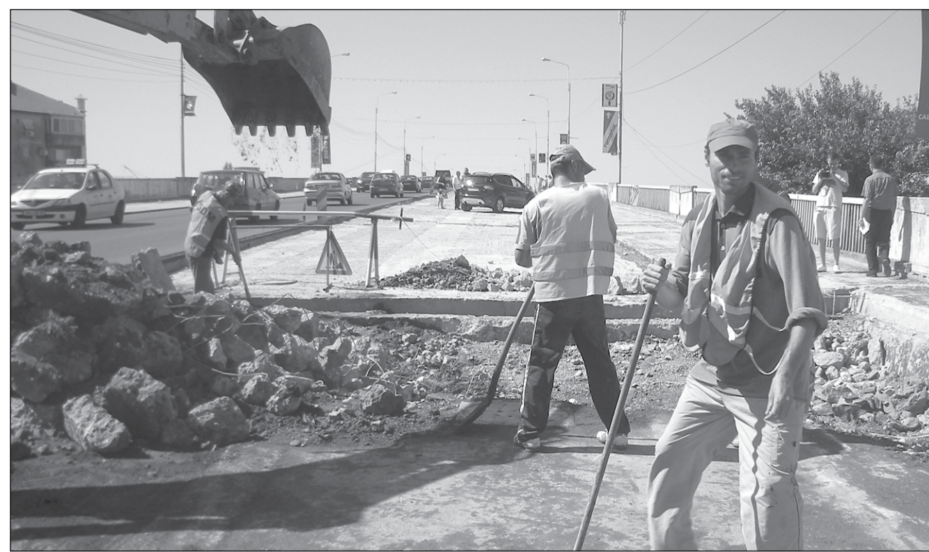
Dacă edilii vor mai vizita șantierul, podul din Calea Șagului va fi gata în noiembrie
