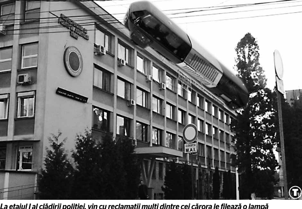
La etajul I al clădirii poliției, vin cu reclamații multi dintre cei cărora le filează o lampă
