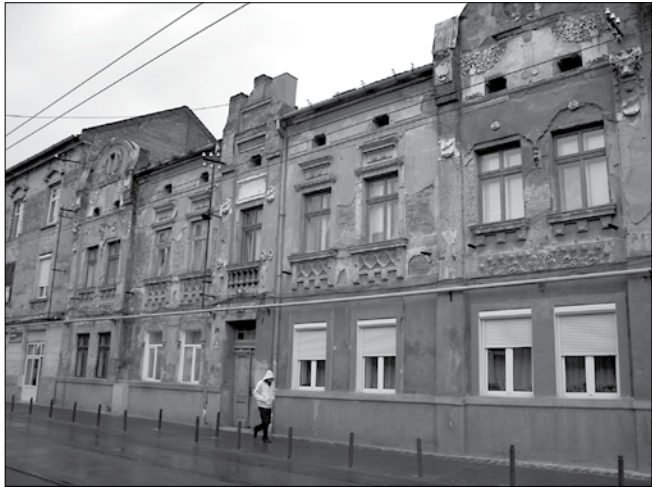
Clădirea de pe strada Prayer nr. 5
