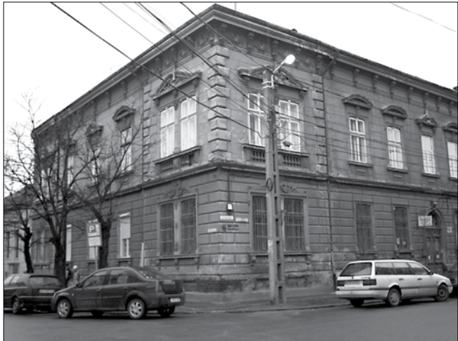
Clădirea de pe strada Timotei Cipariu nr. 10
