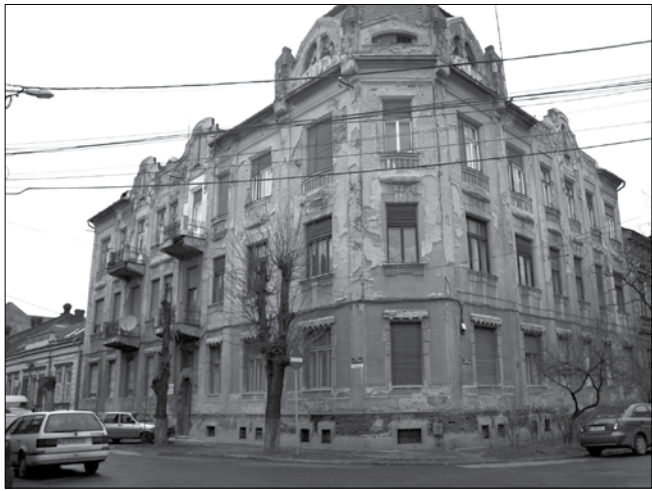
Clădirea de pe strada Timotei Cipariu nr. 11
