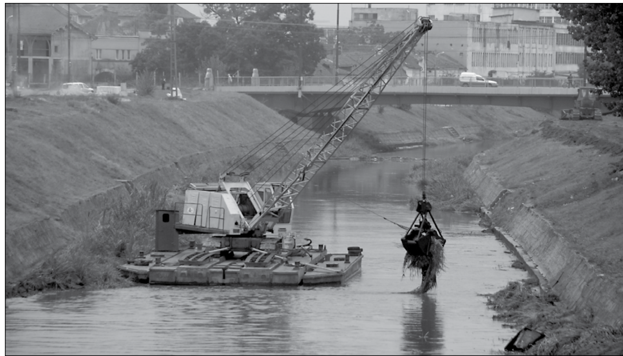
Decolmatarea canalului Bega între Uzina de Apă și Sânmihai se va finaliza în luna iulie
