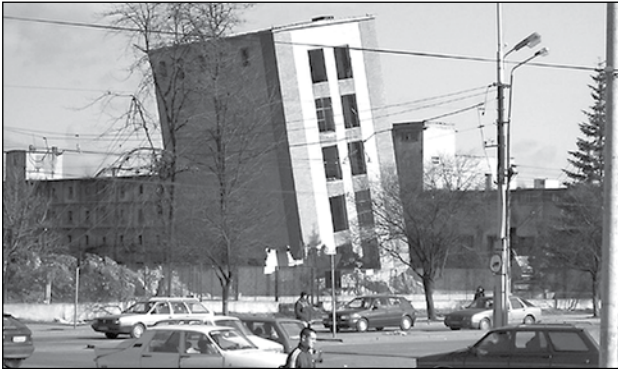
Clădirea BegaPam în timpul demolării
